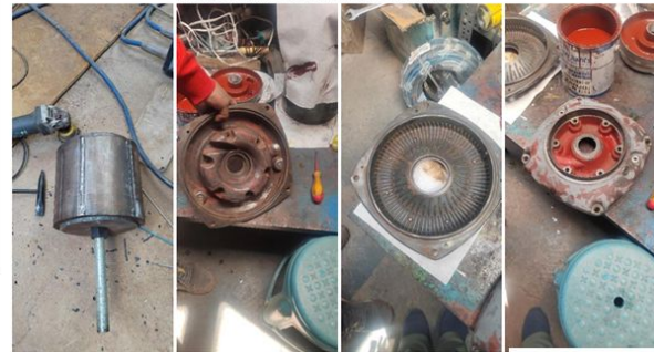
DESMONTAJE DE LA BOMBA A REPARAR
