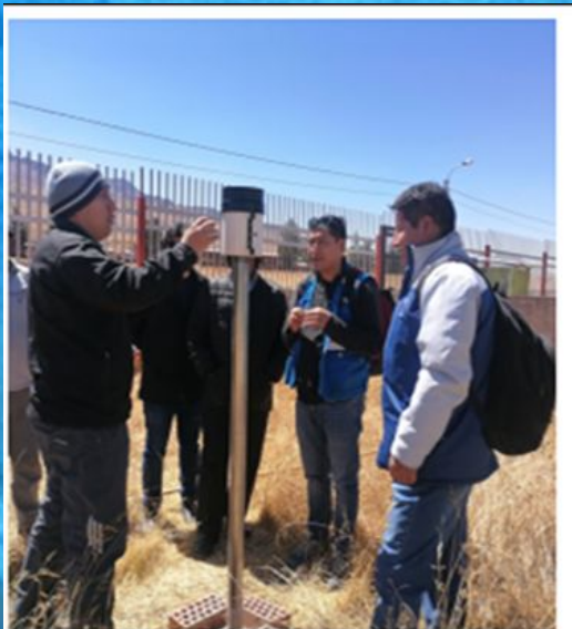
INSTALACIÓN DE UN PLUVIÓMETRO EN LA I.E. JEC TÉCNICO AGROPECUARIO DE LAYO
