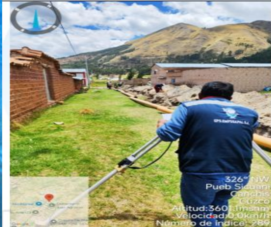
NIVELACION DE LA ZANJA PARA TENDIDO DE TUBERIA DE ALCANTARILLADO
