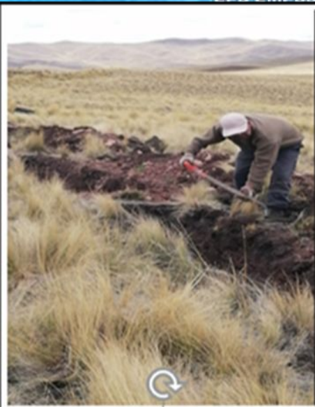
APERTURA DE ZANJAS DE INFILTRACIÓN 2DO AÑO REGULATORIO
