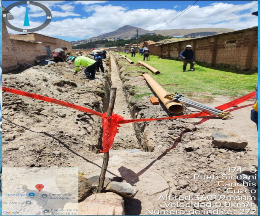
PERFILADO DE ZANJA CON CAMA DE APOYO
